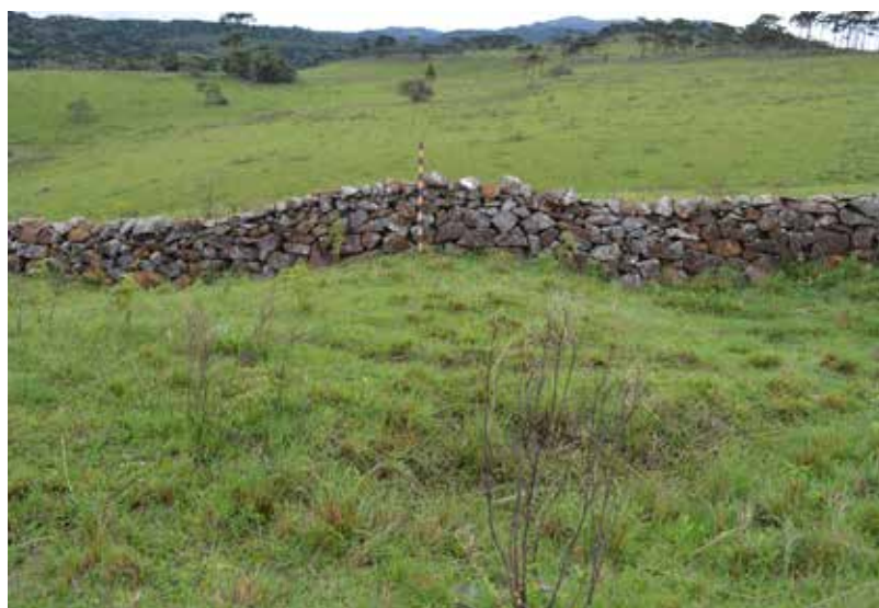
Vista das estruturas subterrâneas cortadas pela taipa de pedra. Fonte: Os autores (2019).
